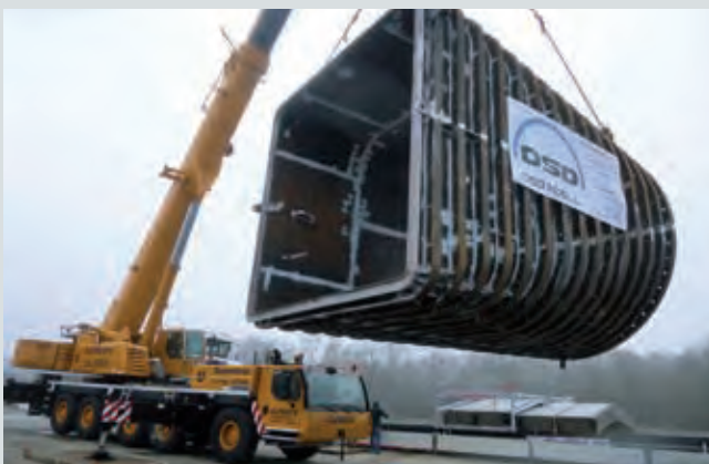
Panzerung Übergang - Transition Steel Liner
