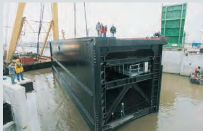
Einschwimmen - Floating in Position
