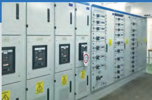
Schaltanlage – Motor Control Center
