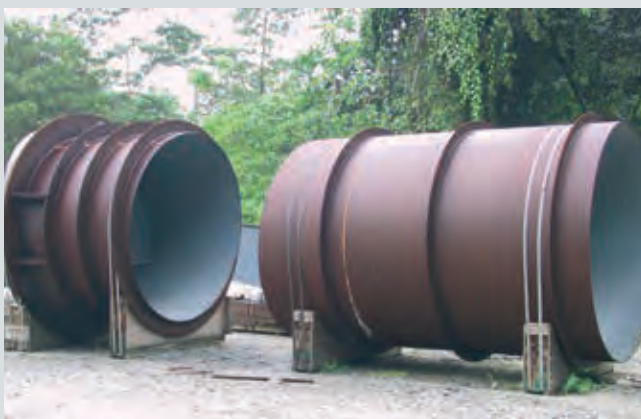
Schachtpanzerung - Steel lining
