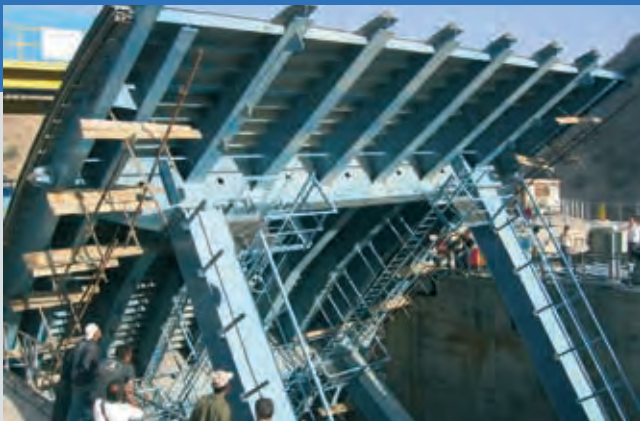
Segment geöffnet – Radial Gate open
