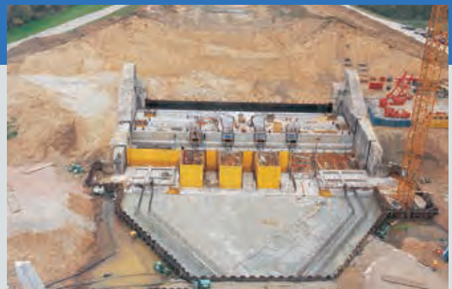
Gründungsarbeiten - Foundation Works
